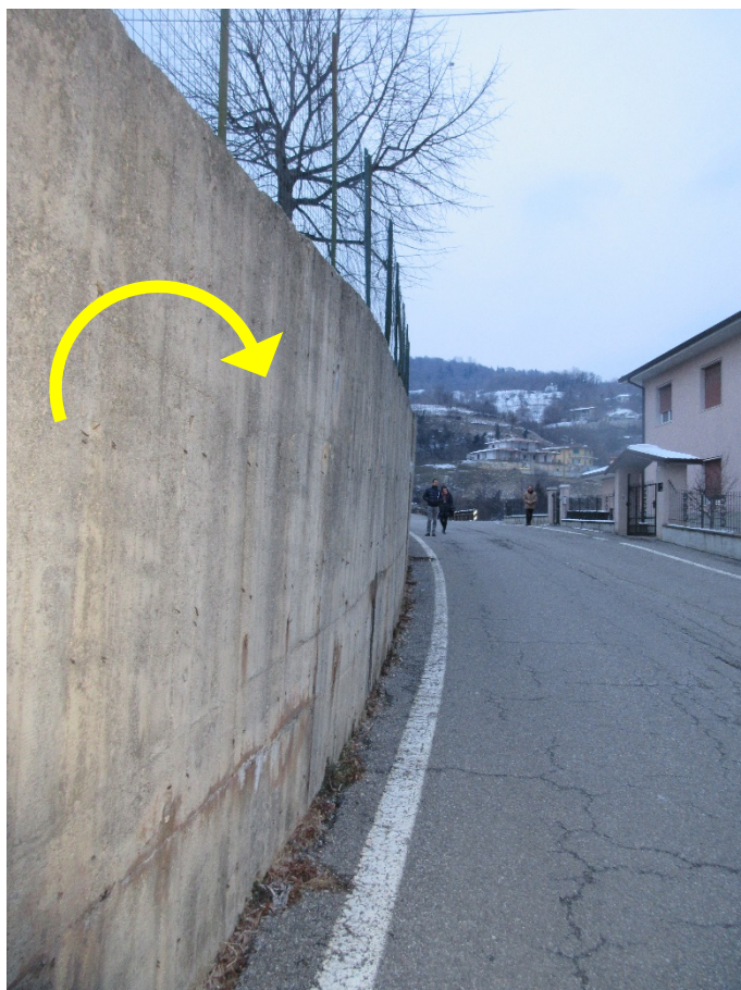
Figura 3: il fuori piombo del muro è chiaramente rilevabile anche a occhio nudo
