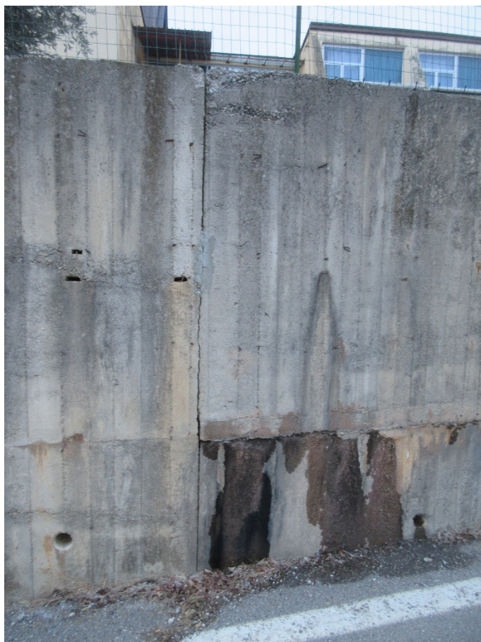
Figura 5: evidenti fessurazioni e trafilamenti di acqua. Si noti che i fori di drenaggio sono praticamente asciutti, a conferma della loro attuale inefficienza. Ciò genera pericolose sovrappressioni e incremento del rischio
