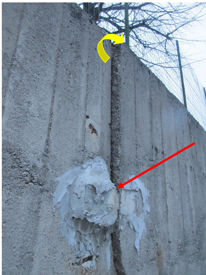
Figura 4: particolare del distacco. Lo spostamento è dell'ordine di svariati centimetri. Si noti la presenza di un riscontro in vetro spezzato (freccia rossa), che pare essere stato posto in opera di recente. La rottura è a testimonianza del fatto che il fenomeno di cedimento e rotazione è in divenire, tutt'altro che esaurito
