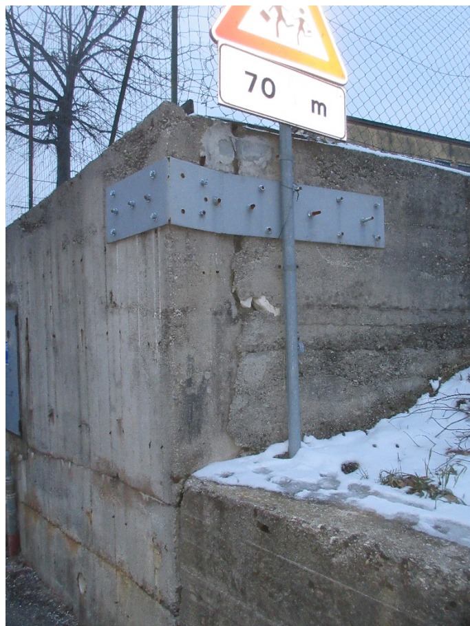
Figura 6: elementi in carpenteria recentemente apposti a trattenimento del muro. Essi per dimensioni ed estensione possono svolgere solo una limitata azione locale, non sufficiente a garantire sicurezza al manufatto
